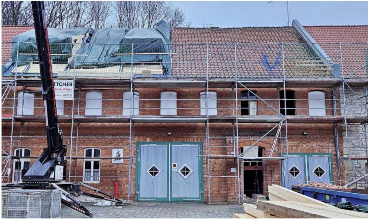
Die Arbeiten am neuen Vereinsheim der Bogenschützen in Röderhof schreiten sichtbar voran.
