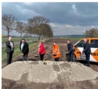
Erster Spatenstich für den Radweg von Dedeleben nach Jerxheim-Bahnhof.
